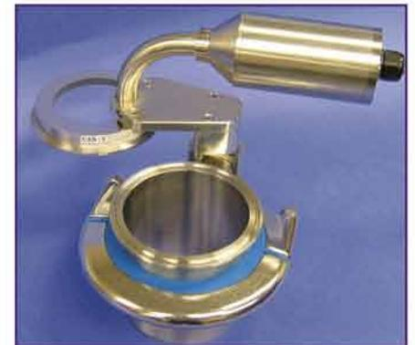
CANTY TRI-PORT™ schwenkbares Steril- Licht und Fusionsglas System. Die PUREVIEW™ Sterilbeleuchtung ist kombiniert mit einem einzigartigen schwenkbaren Fusionsglas, welches sich schnell und einfach entfernen lässt. Das TRI-PORT™ System bleibt vom Klemmring gestützt und kann genauso schnell wieder in den ursprünglichen Zustand geschwenkt werden.
